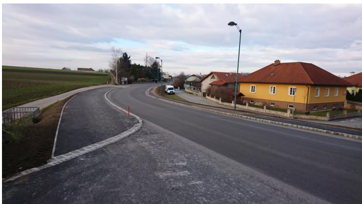
Blick von der unteren Einfahrt Lagerhaus Richtung Schubertstraße nach Fertigstellung
