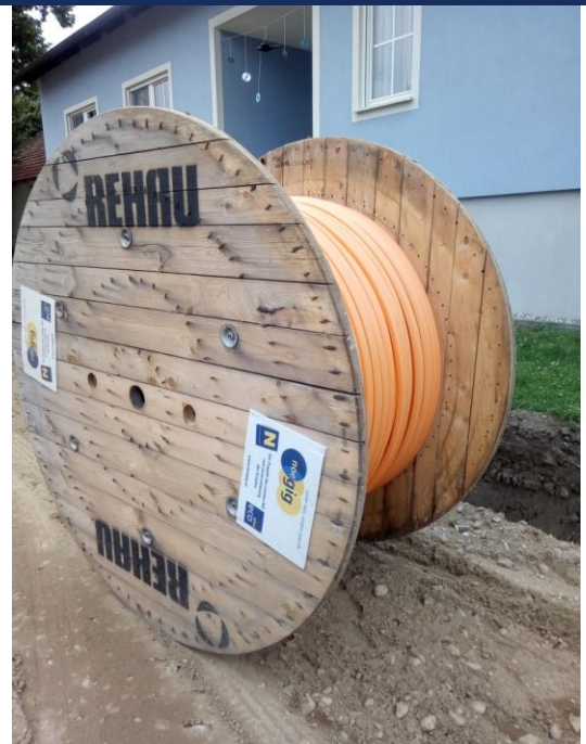
Leerverrohrung für künftiges Breitband
