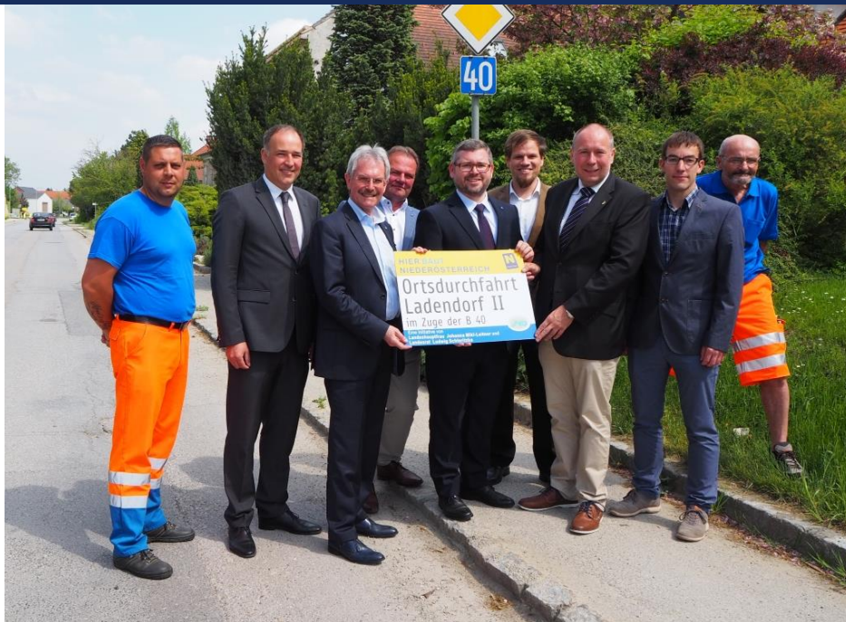
Baubeginn des zweiten Abschnittes zur Erneuerung der Ortsdurchfahrt Ladendorf im Zuge der B40
