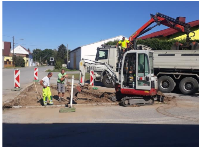
Maßnahme zum Hochwasserschutz in der Kapellenstraße Ladendorf
