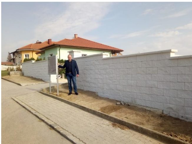
Neue Friedhofsmauer in Neubau
