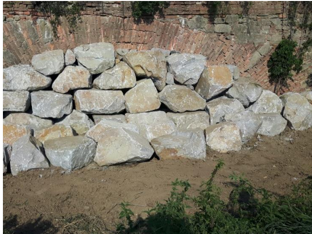
Rasch installierte Hochwasserschutzmaßnahme im Einlaufgebiet nach Ladendorf
