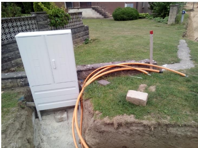
Glasfaserleerverrohrung wird bei neuen Straßen mitverlegt
