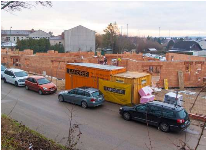
Die Grundzüge des neuen Kindergartens sind schon deutlich zu erkennen.
