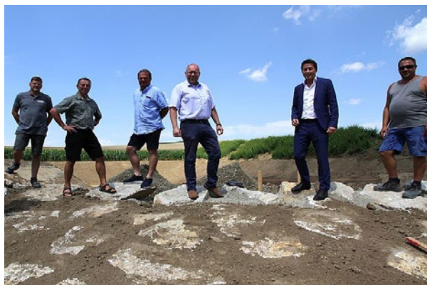
Übergabe der neuen Becken in der KG Eggersdorf
